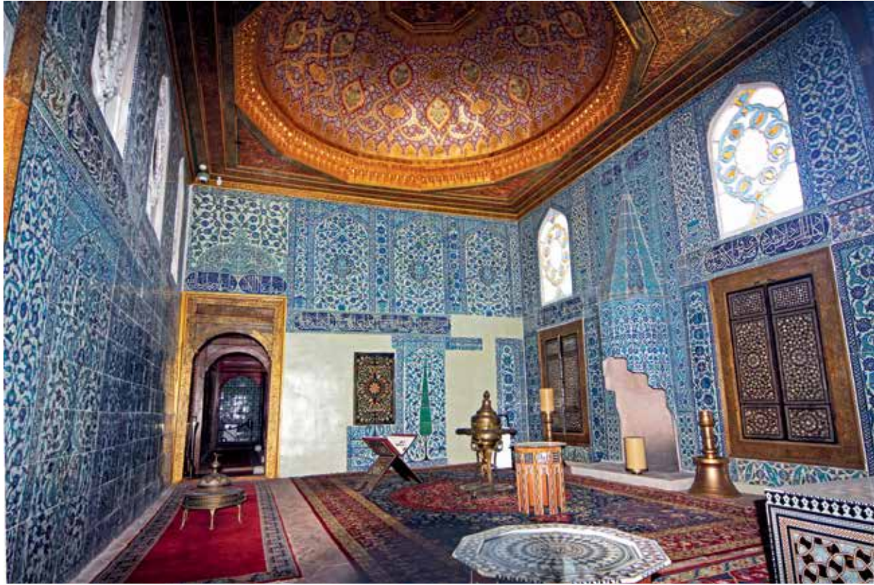
Vâlîde Sultan odası (Pencerelerden kapıya doğru). Odanın tavanı bir tarafı ahşap tonoz, bir tarafı ahşap kubbeyle örtülüdür. Kasrın her tarafında olduğu gibi burası da yerden tavana kadar çiniyle kaplanmıştır. Ahşap tavan ise kalem işleriyle süslüdür. Kapılar ve dolap kapakları da sedef kaplamalı ve Edirnekâri süslemelidir. Karşıdaki giriş kapısının sağından itibaren pencere altlarında Âsımî'nin yazdığı şiirin 15 beyti, odayı çepeçevre dolanmakta yine kapının solundaki beyitle bitmektedir. Kapının üstünde ise şiir haricinde “ Eşhedü en lâ ilâhe ill(Â)llâh ve eşhedü enne Muhammeden Rasûl(A)llah ” yazılıdır.
