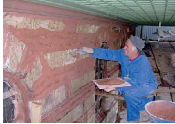
Binanın dış cephesi temizlenmiş, cephelerdeki taş yüzeylerde oluşan kırılma ve kopmalar yenilenmiş, binanın içinde ve dışında sonradan yapılmış çimento harçlı sıvaların tamamı sökülerek orijinalinde olduğu gibi Horasan harcıyla sıvanmıştır.
