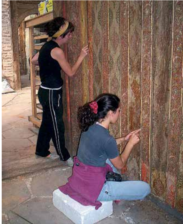
Köşkün içindeki bütün Edirnekâri işler elden geçirilmiş ve enjeksiyon uygulanmıştır.
