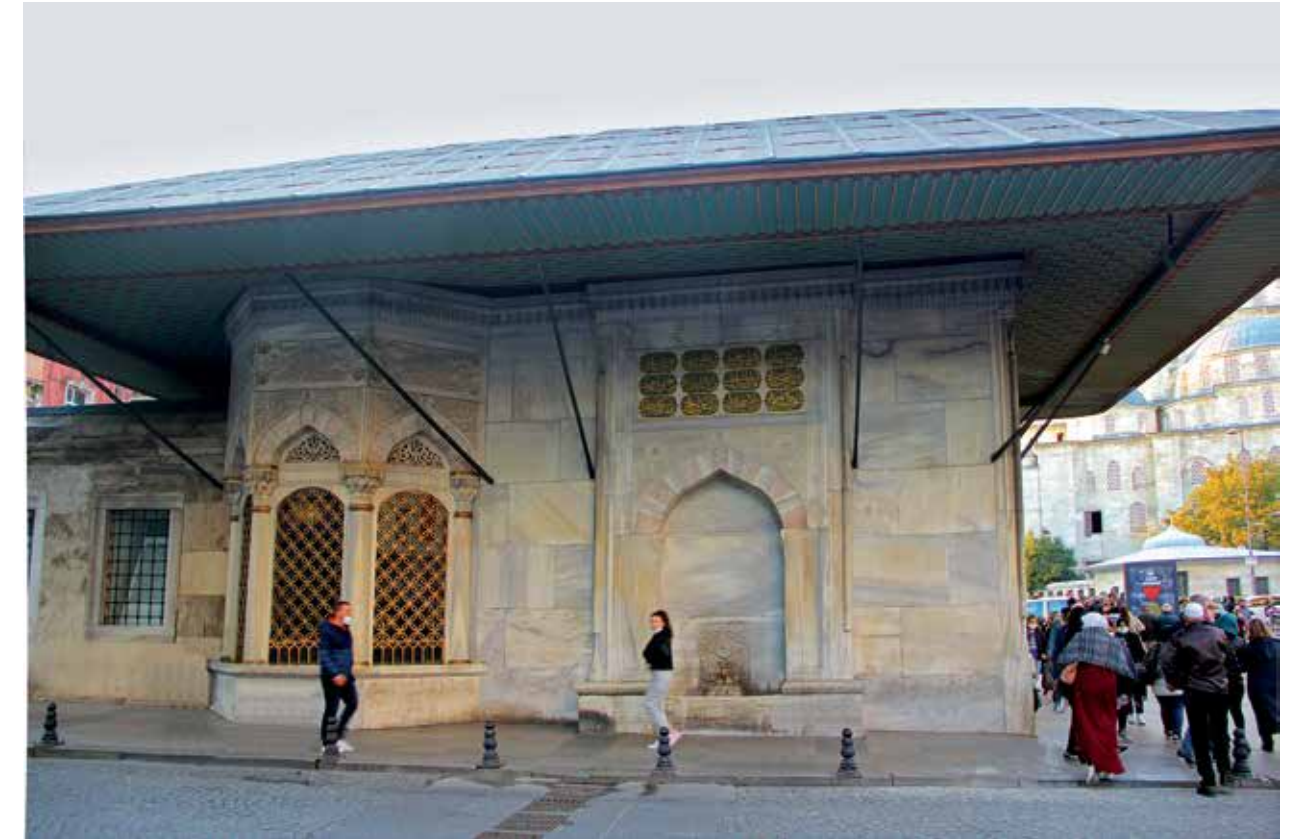
Çeşme ve sebil bitişiktir. Üzeri geniş bir saçakla örtülüdür. Arkasında da su haznesi vardır.
