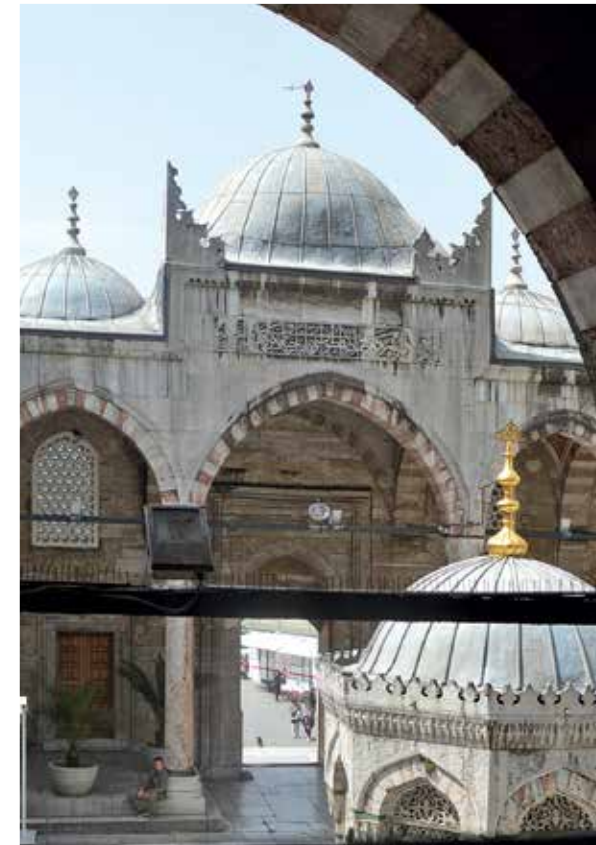
Cami avlusuna girilen kuzey kapısının iç taraftan görünüşü (Fot. Kübra Çelik)
