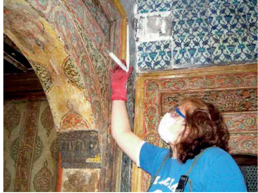
Köşkün içindeki bütün Edirnekâri işler elden geçirilmiş ve enjeksiyon uygulanmıştır.
