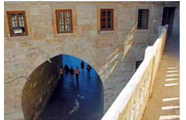
Hünkâr Kasrı Tahtırevân Yolu balkonundan birinci kat ve alt geçit.
