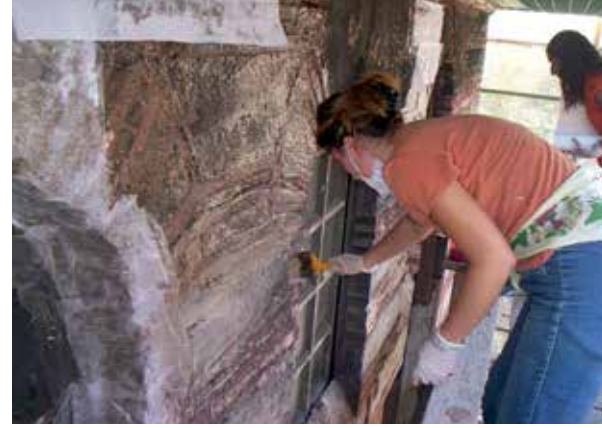
Binanın dış cephesi temizlenmiş, cephelerdeki taş yüzeylerde oluşan kırılma ve kopmalar yenilenmiş, binanın içinde ve dışında sonradan yapılmış çimento harçlı sıvaların tamamı sökülerek orijinalinde olduğu gibi Horasan harcıyla sıvanmıştır.
