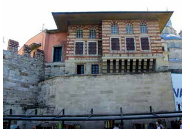
Gömlekli Kule'ye de raspa uygulaması, sıva ve Horasan sıva uygulaması yapılmıştır. Kasrın tamirden önceki ve sonraki hali görülüyor.
