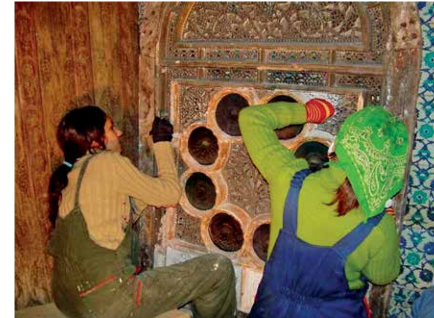
Revzenler sökülüp onarılmış, camları yenilenmiş, içlik ve dışlık pencereler de sökülüp tamir edilerek yerine takılmıştır.
