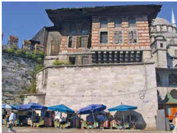
Gömlekli Kule'ye de raspa uygulaması, sıva ve Horasan sıva uygulaması yapılmıştır. Kasrın tamirden önceki ve sonraki hali görülüyor.
