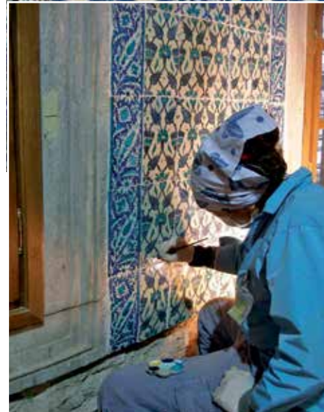
Çiniler bütünüyle sökülüp tamiri yapılarak yerlerine yerleştirilmiştir. Üstte sofadan bir çini pano.
