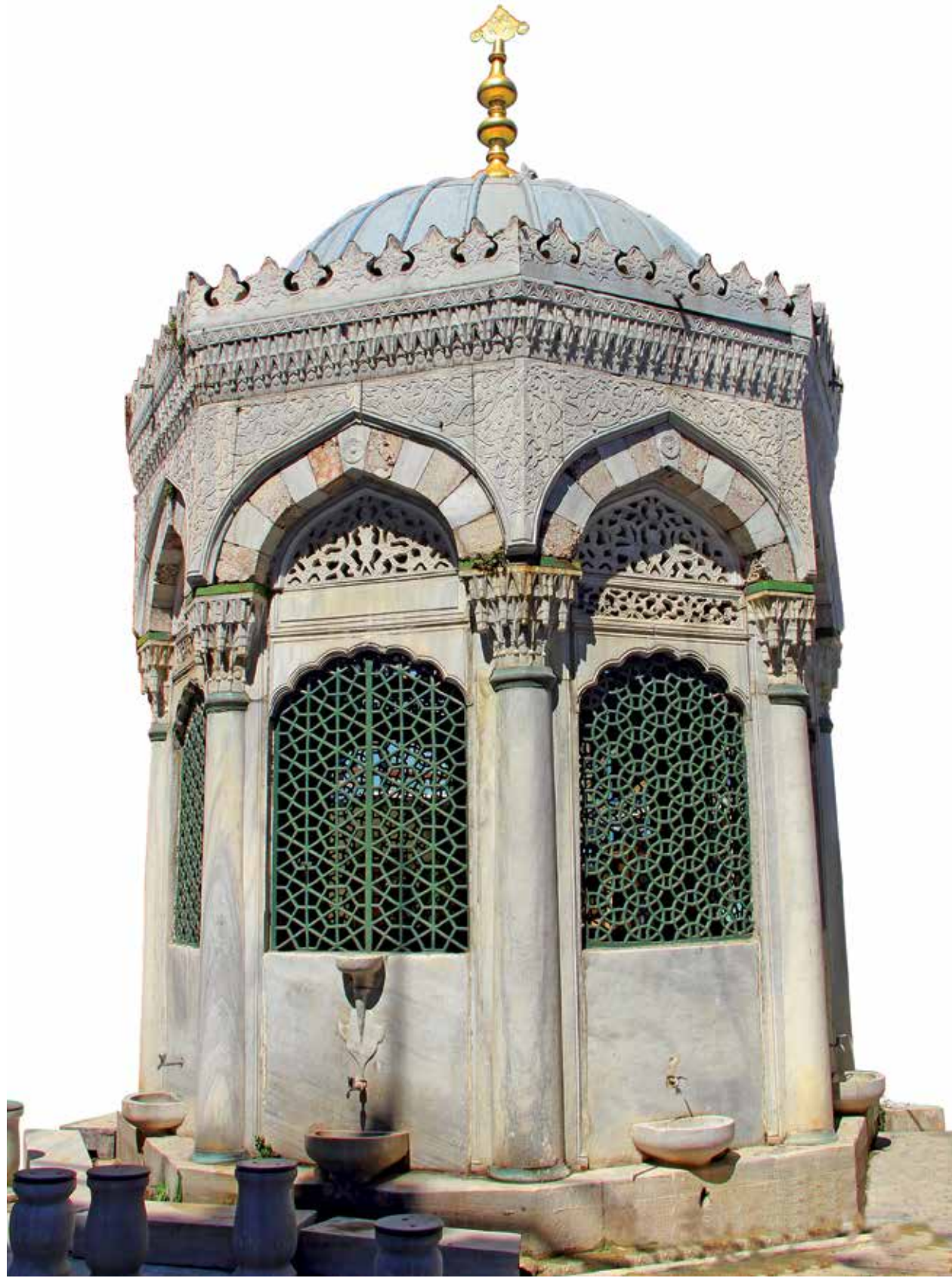
Caminin iç avlusunun ortasında yer alan, sekiz cepheli, taş kabartmalı, devrinin en güzel örneklerinden nâdide şadırvan.
