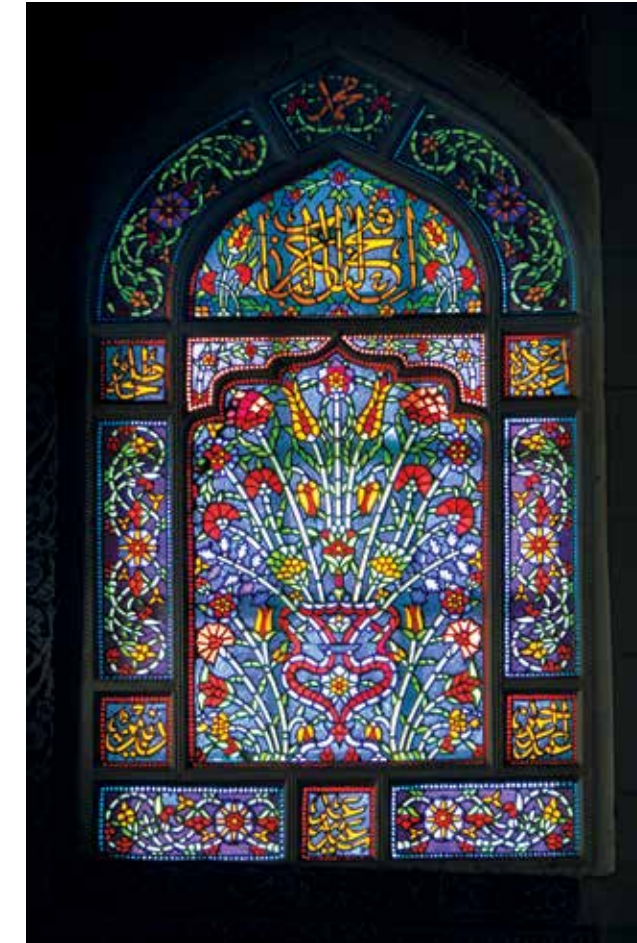
Revzenler sökülüp onarılmış, camları yenilenmiş, içlik ve dışlık pencereler de sökülüp tamir edilerek yerine takılmıştır.
