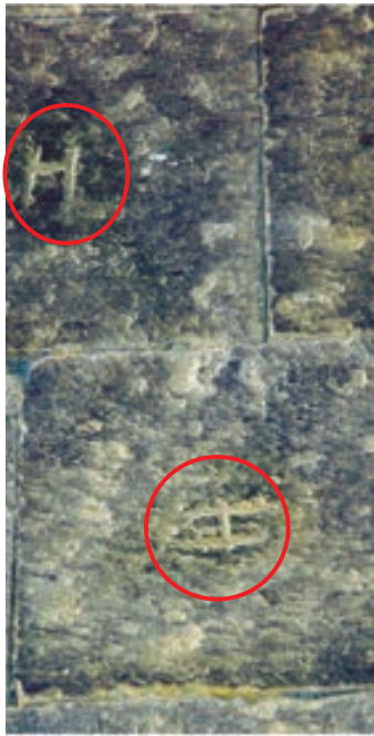
Binanın çeşitli yerlerinde kesme taşlar üzerinde görülen taşçı işaretlerinden örnekler
