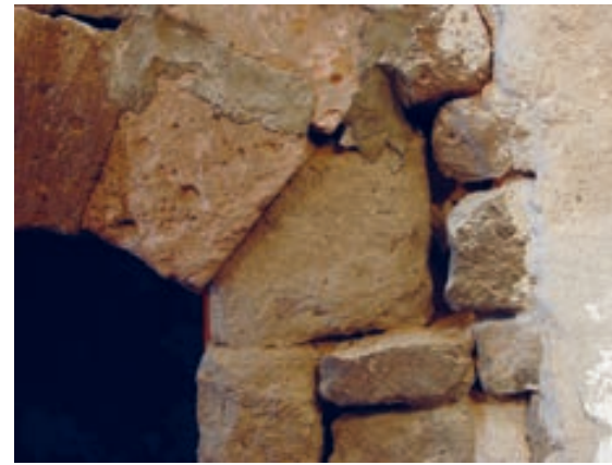
Akıl hastalıkları bölümündeki hasta odalarından birisinin kapısı tamir sırasında S.Ünver'in isteğiyle orjinal haliyle bırakılmıştır.
