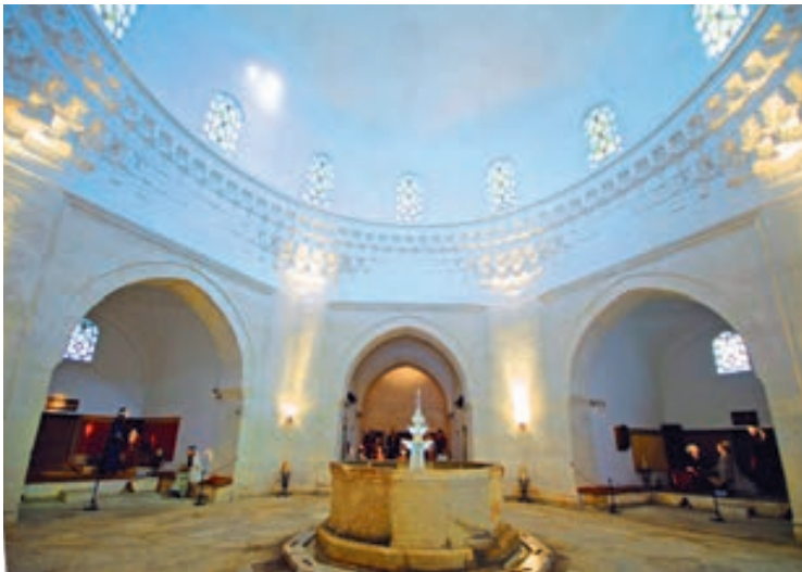
Edirne dârüşşifâsında ortada büyük kubbe ile bunu çevreleyen on iki küçük kubbenin örttüğü altı köşeli ana blok
