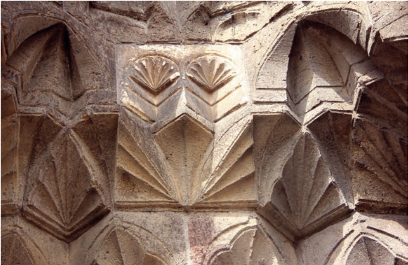
Gevher Nesibe Şifâhânesi taçkapısından taş kabartma detaylar.
