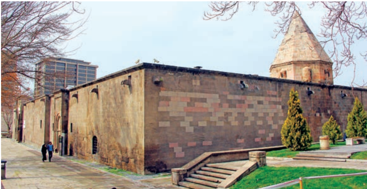
Yapının güney doğu köşesinden medrese kısmı ve Gevher Nesibe'nin kümbeti, 2018
